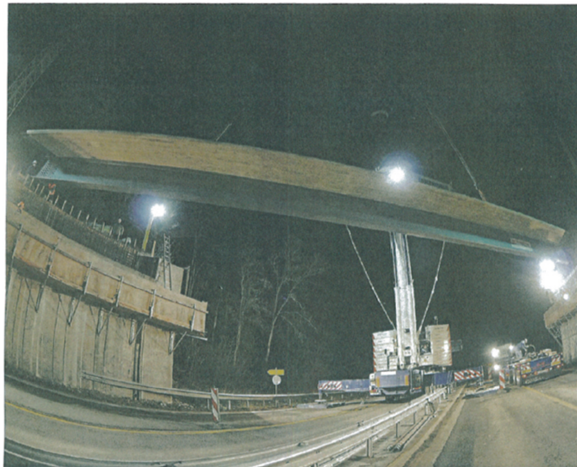
Millimeterarbeit: Das Brückenelement schwebt ein und wird exakt platziert.
