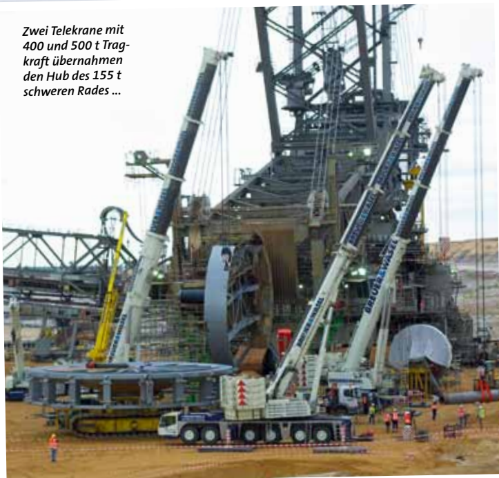
... während ein 350-Tonner als Nachführkran zum Einsatz kam.
